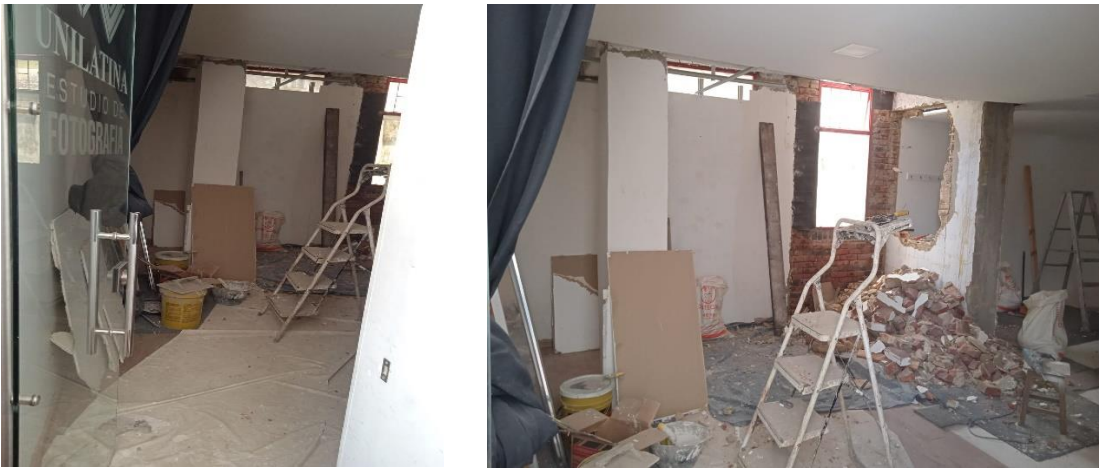
Remodelación estudio fotografía 3 piso
